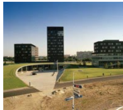
(kantoor snelweg Utrecht)
